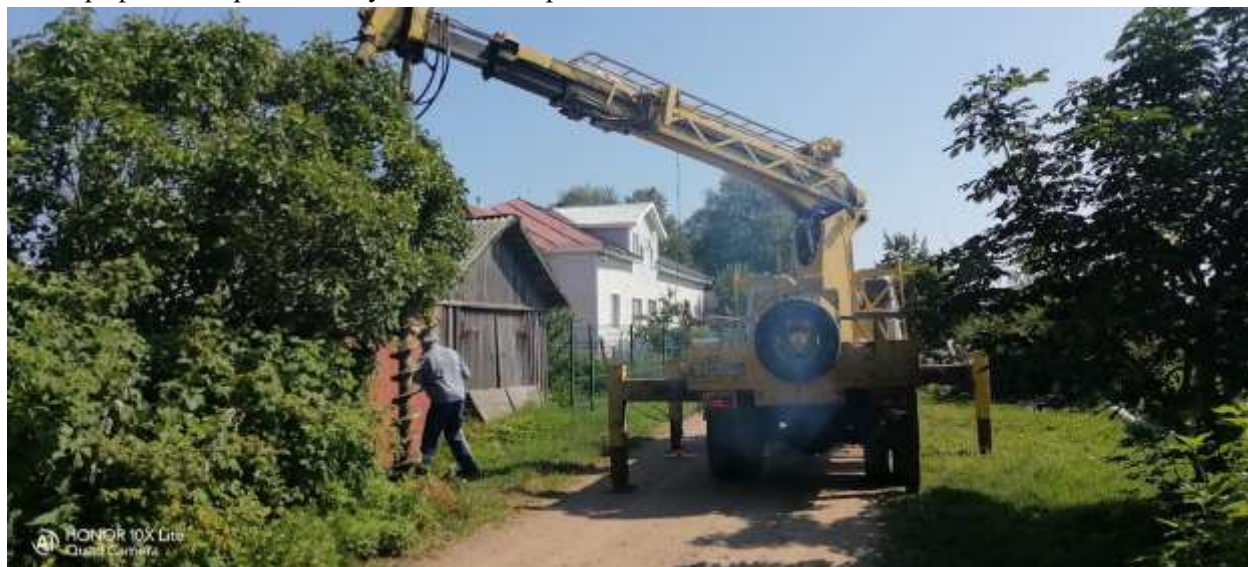
Фотография №9 «работы по установке опор»
