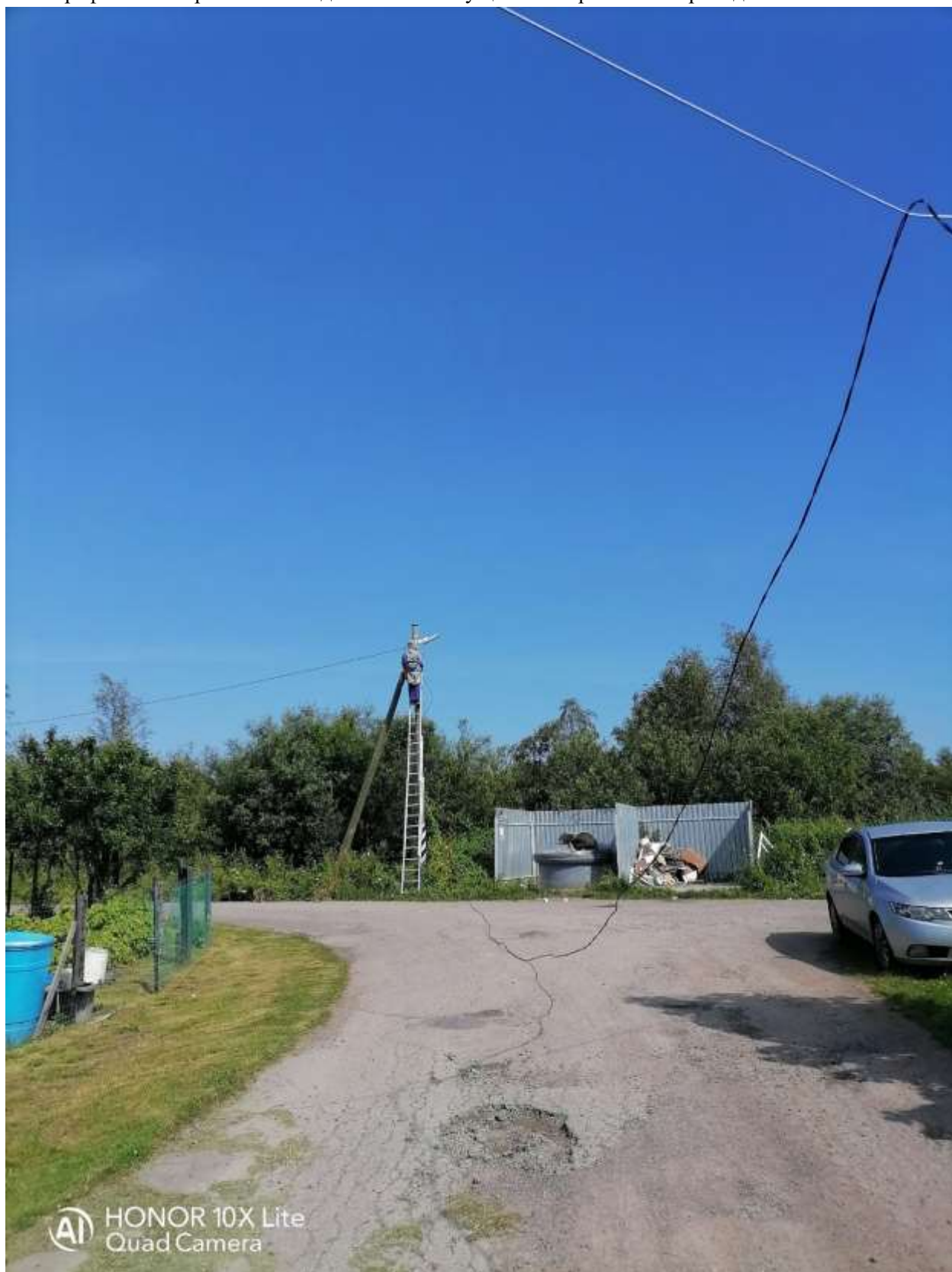
Фотография № 10 «работы по подвеске самонесущих изолированных проводов»
